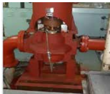
طراحی و ساخت اولین پمپ دو مکشه عمودی با آلیاژ Stainless Steel به سفارش پایانه نفتی خارک
